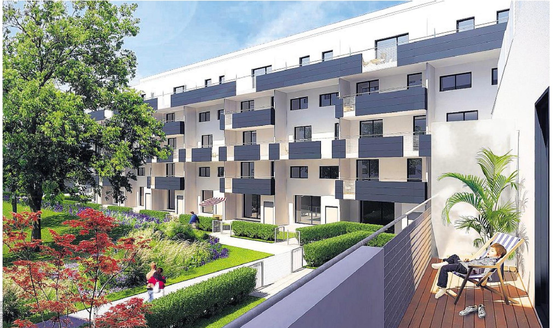
Passivhaus: Es ist im kommunalen Wohnbau in Wien bereits zum Standard geworden – kein Wunder, wenn die Heizkosten im Vergleich zu einem Altbau nur noch bei 10 Prozent liegen. Im Bild das Passivhaus-Projekt Erzherzog-Karl-Sträße (siehe auch Seite 3)
