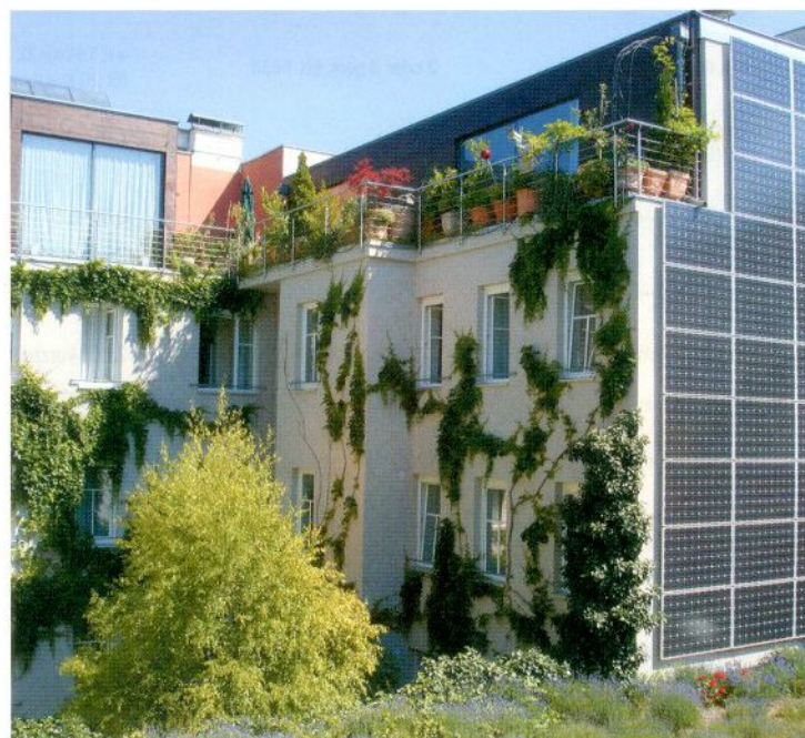
Die südseitige Photovoltaikanlage ist eine jener Energiequellen, die ebenso viel Energie erzeugen, wie verbraucht wird.
